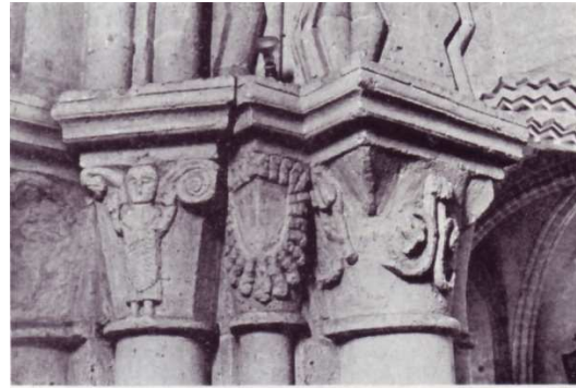
FIG. 14. — SAINT-LUCIEN DE BURY, CHAPITEAUX DU BAS-CÔTÉ NORD DE LA NEF
