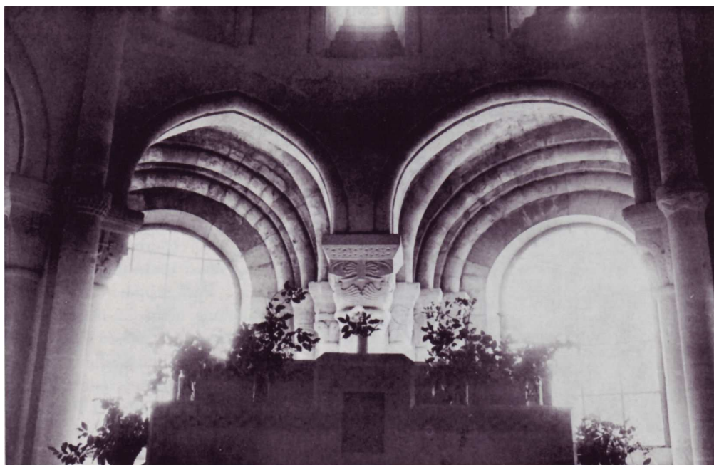
FIG. 6. — NOTRE-DAME DE MORIENVAL, FENÊTRES ET PILIER AXIAL DU DÉAMBULATOIRE
